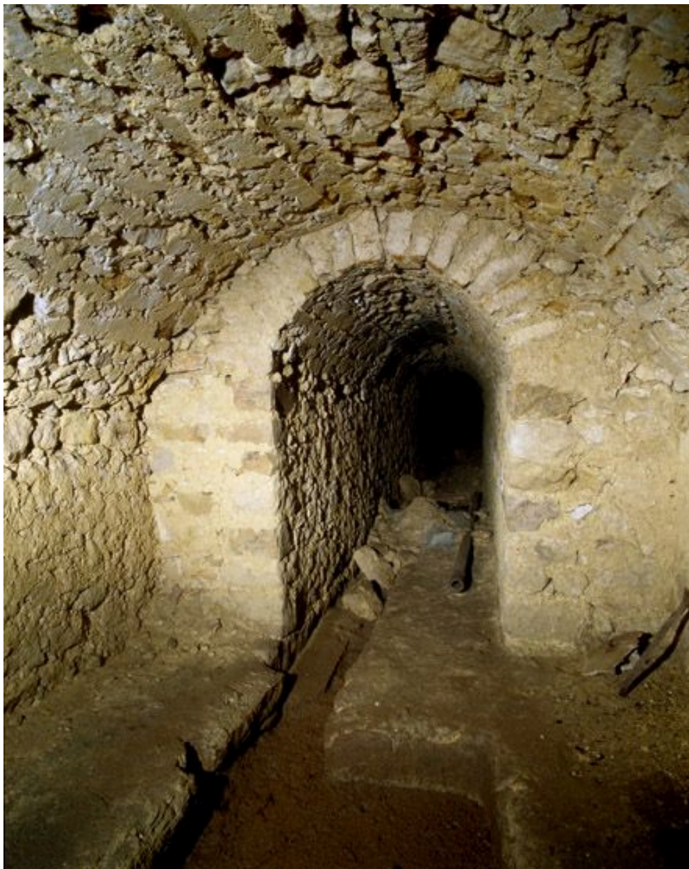
La salle sud et le départ de la conduite allant vers l'ancien couvent des Récollets (actuel hôpital de Melun).
