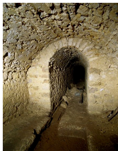
La salle sud et le départ de la conduite allant vers l'ancien couvent des Récollets (actuel hôpital de Melun). Phot. Stéphane Asseline IVR11_20077700111XA
