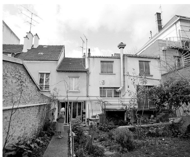
Elévation est, sur le jardin. Phot. Stéphane Asseline IVR11_20027701045X
