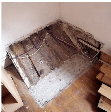
Vue intérieure : planches formant la couverture de la cage d'escalier, dans les combles. Phot. Stéphane Asseline IVR11_20057700203XA
