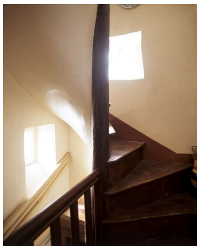
Vue intérieure : l'escalier en vis à l'arrière du logis. Phot. Stéphane Asseline IVR11_20057700201XA
