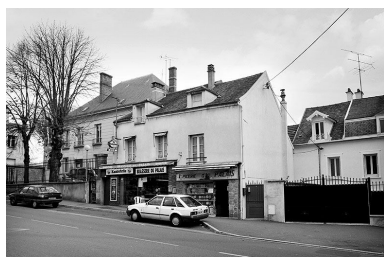
Elévation ouest, sur la rue du général de Gaulle. Phot. Stéphane Asseline IVR11_20027701042X
