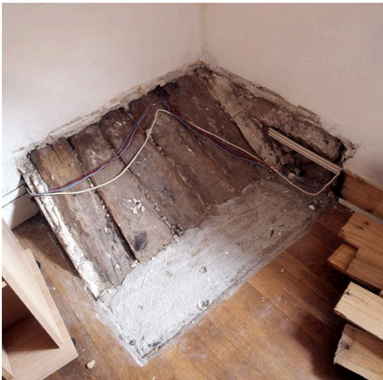
Vue intérieure : planches formant la couverture de la cage d'escalier, dans les combles.
