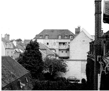
Vue d'ensemble de la propriété, depuis le sud. La maison étudiée présente son pignon sud (aveugle) sur la droite du cliché. Phot. Stéphane Asseline IVR11_20027700709X
