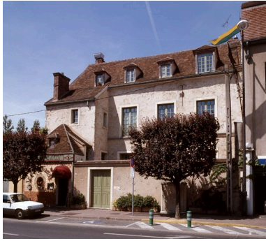
Vue de l'élévation est, vers le boulevard. Phot. Stéphane Asseline IVR11_20057700261XA
