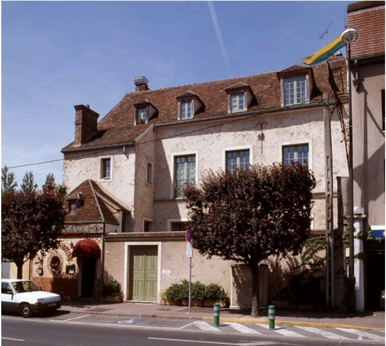
Vue de l'élévation est, vers le boulevard.
