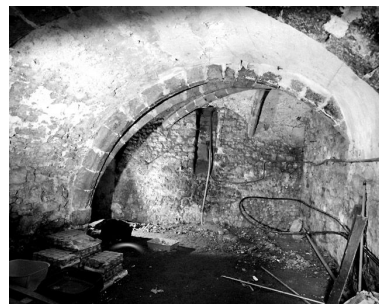
La cave : vue depuis l'entrée. Phot. Stéphane Asseline IVR11_20027700743X
