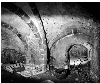
La cave : vue prise depuis l'angle nord-ouest. Phot. Stéphane Asseline IVR11_20027700742X
