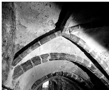
La cave : vue depuis l'ouest, avec la voûte d'ogives. Phot. Stéphane Asseline IVR11_20027700744X
