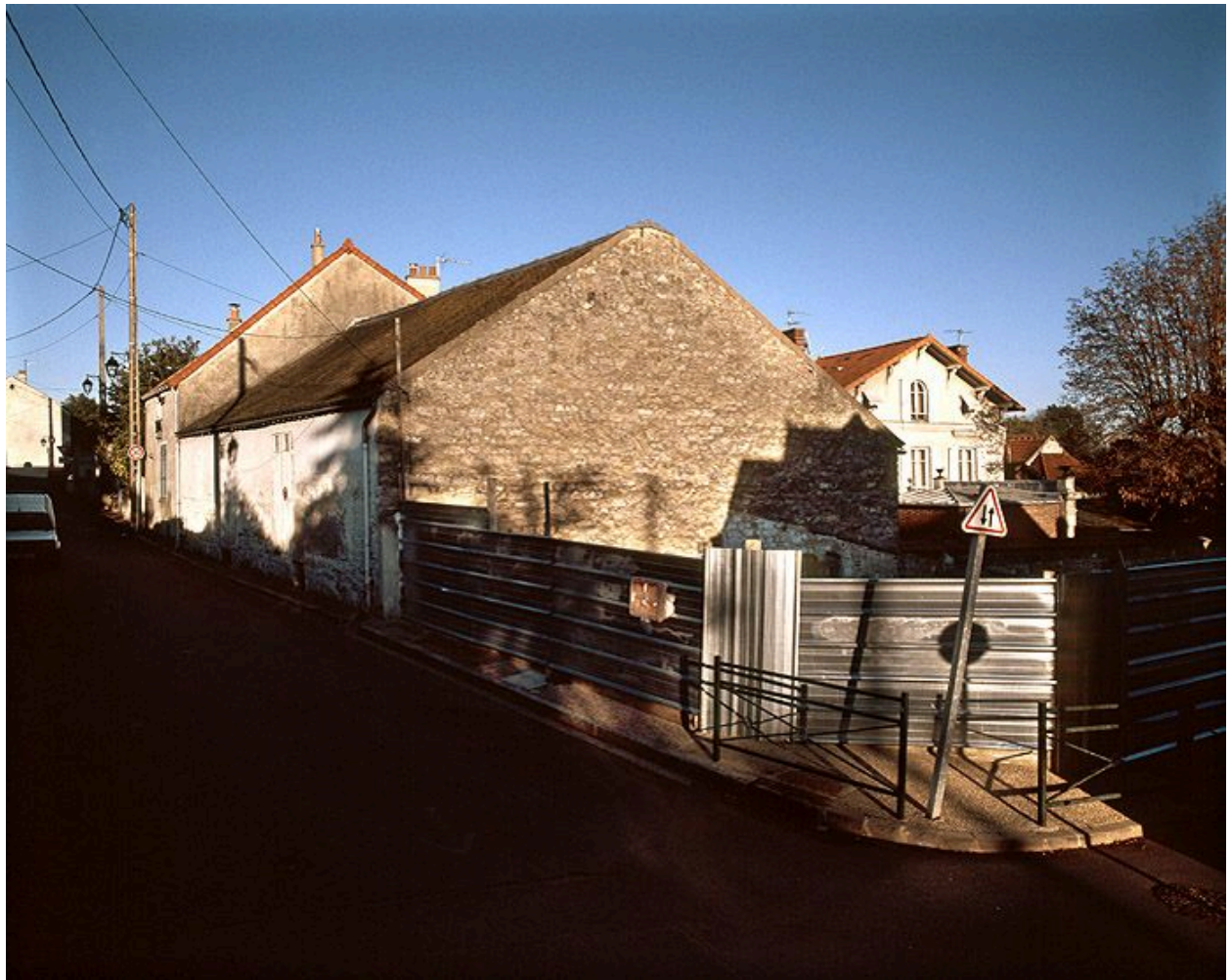
La façade arrière sur la rue des Courcieux de l'ancienne grange.
