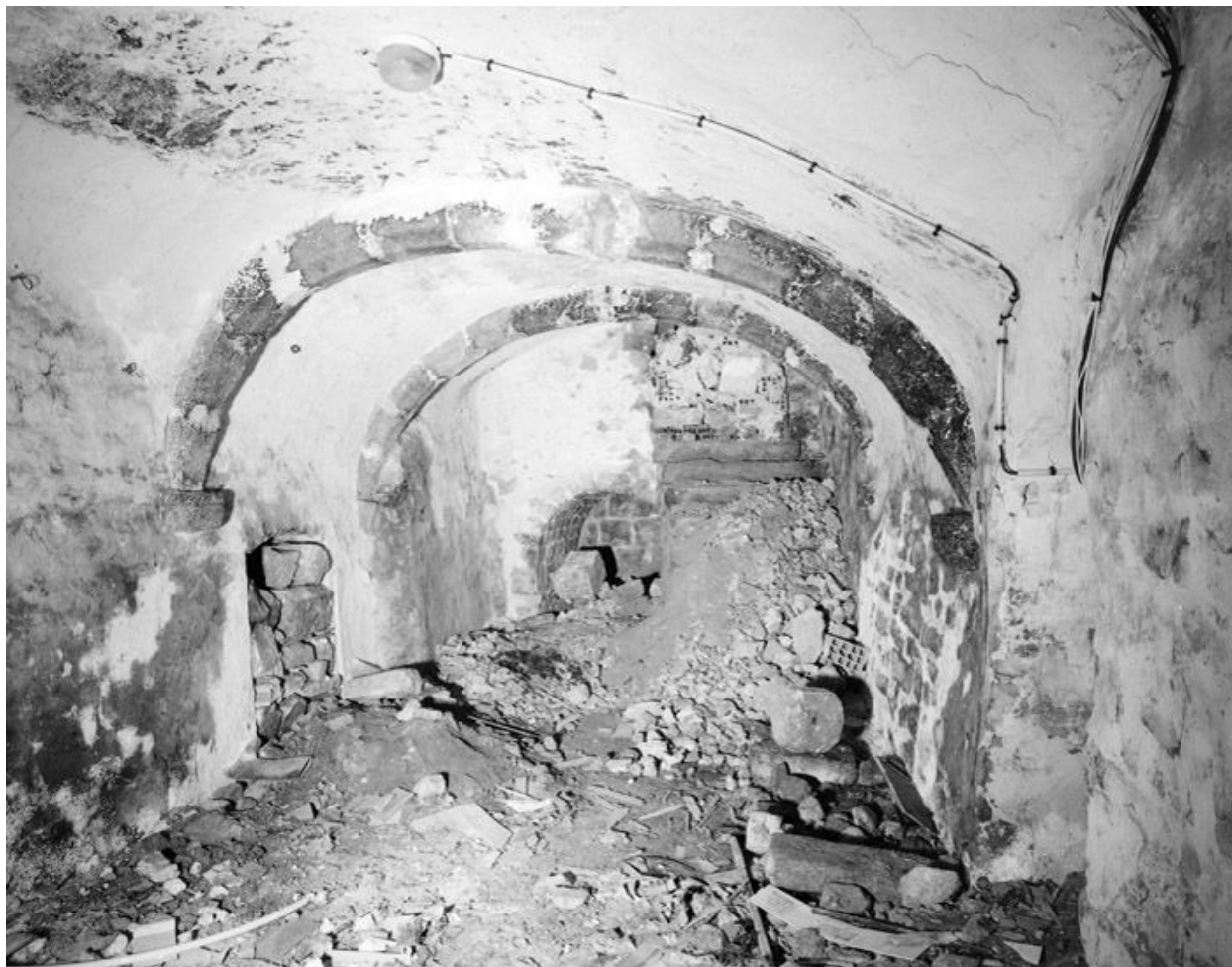
La cave : vue d'ensemble du berceau avec arcs doubleaux, depuis le sud-est.
