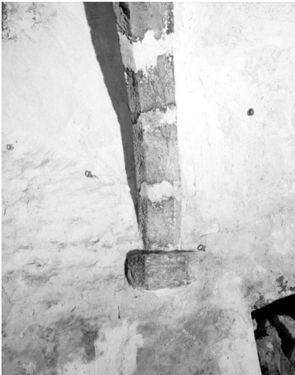
La cave : détail d'un corbeau.
