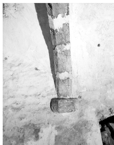
La cave : détail d'un corbeau. Phot. Stéphane Asseline IVR11_20067700008X
