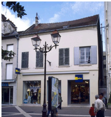
Vue de la façade. Phot. Stéphane Asseline IVR11_20077700031XA
