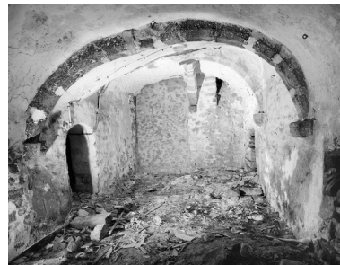
La cave : vue d'ensemble du berceau avec arcs doubleaux, depuis le nord (vers la rue). Phot. Stéphane Asseline IVR11_20067700004X
