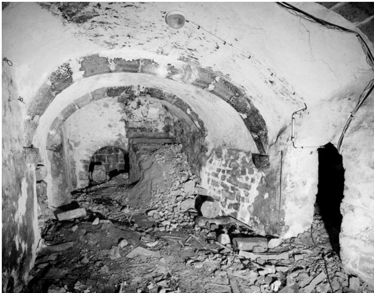
La cave : vue d'ensemble du berceau avec arcs doubleaux, depuis le sud (vers la cour).
