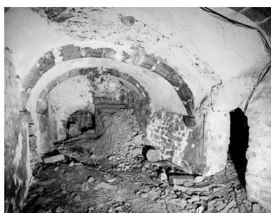
La cave : vue d'ensemble du berceau avec arcs doubleaux, depuis le sud (vers la cour). Phot. Stéphane Asseline IVR11_20067700006X
