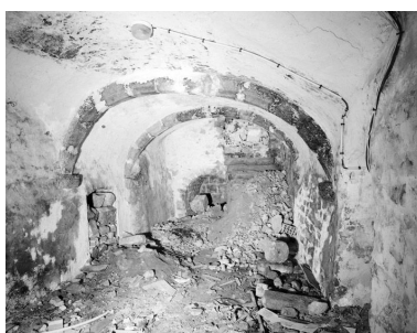
La cave : vue d'ensemble du berceau avec arcs doubleaux, depuis le sud-est. Phot. Stéphane Asseline IVR11_20067700007X
