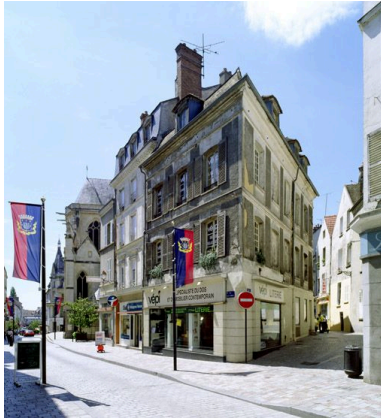
Vue d'ensemble. Phot. Stéphane Asseline IVR11_20037700649VA
