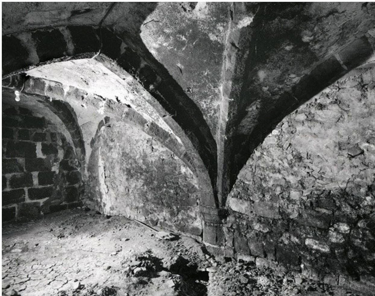
La cave médiévale : le pilier central, aujourd'hui inclus dans la maçonnerie.
