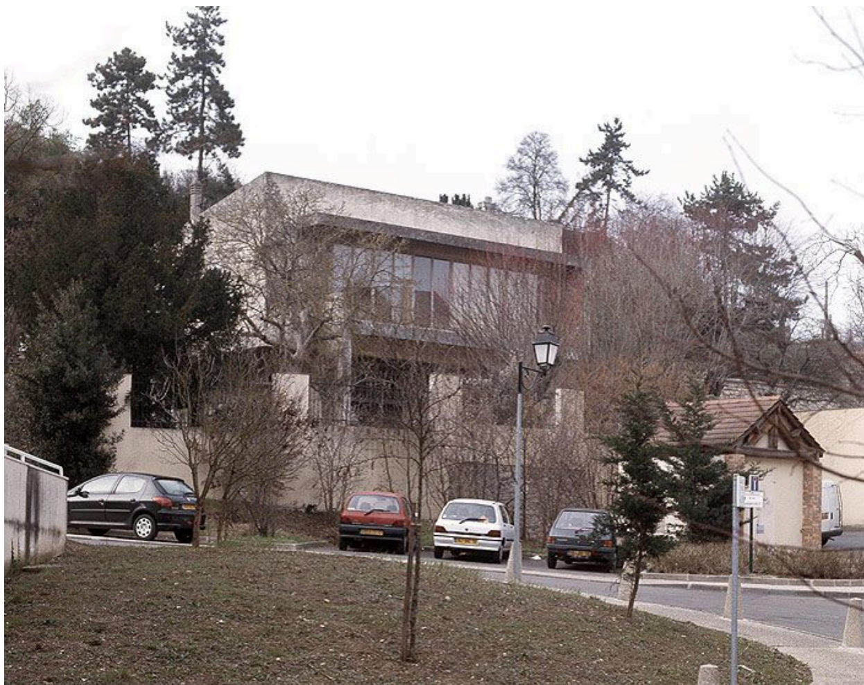
Vue d'ensemble de la façade tournée vers le panorama.
