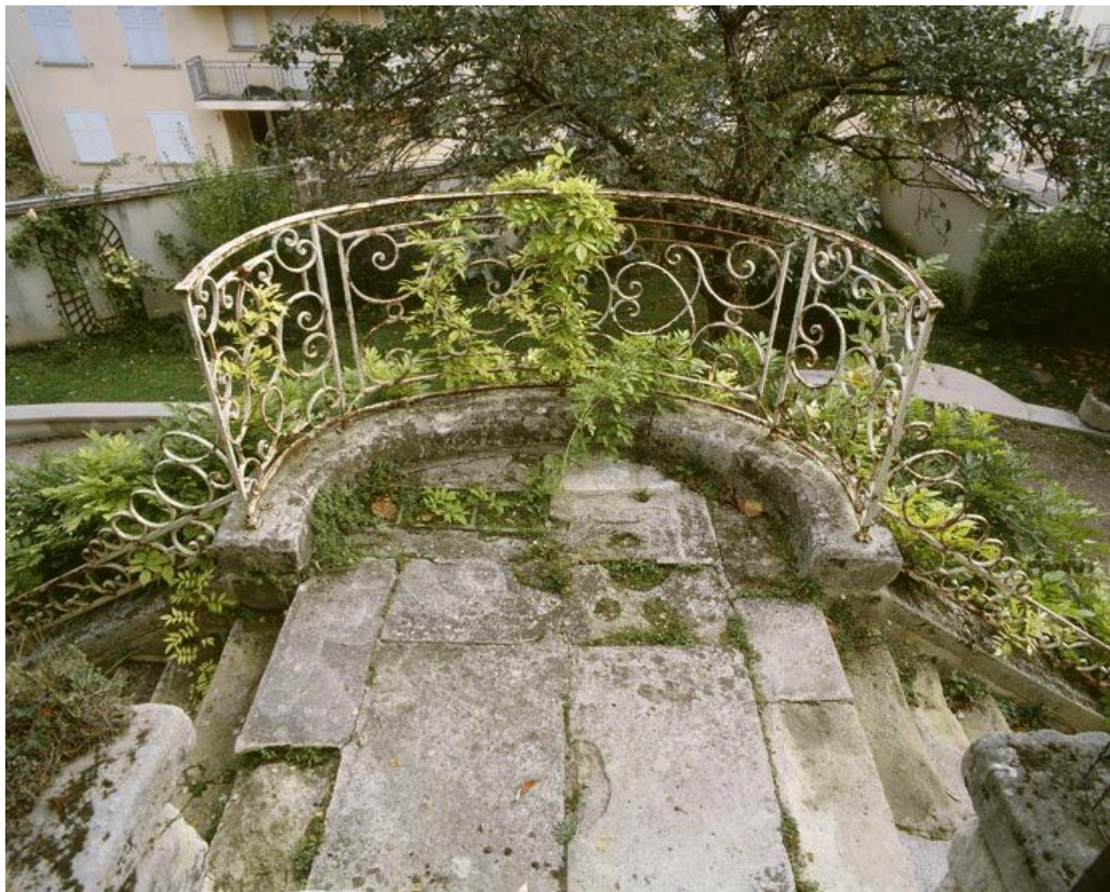
Le belvédère, vue du garde-corps.
