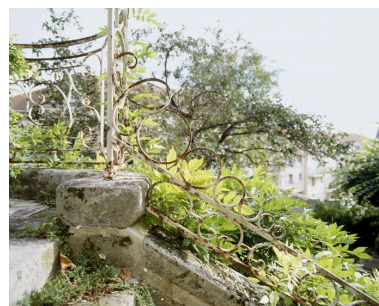
Le belvédère, détail du garde-corps latéral. Phot. Laurent Kruszyk IVR11_20067800754XA
