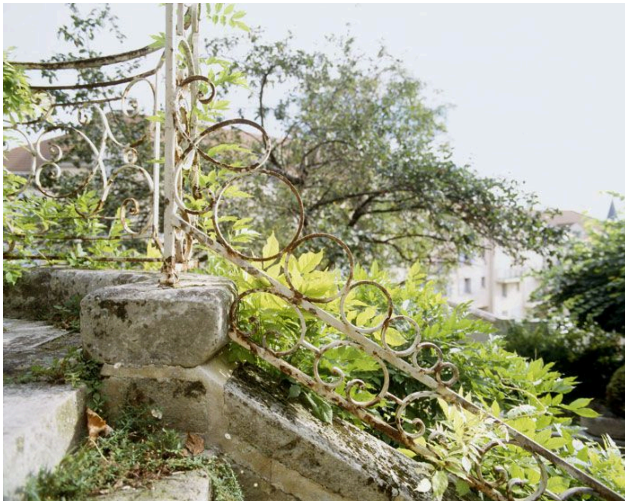
Le belvédère, détail du garde-corps latéral.
