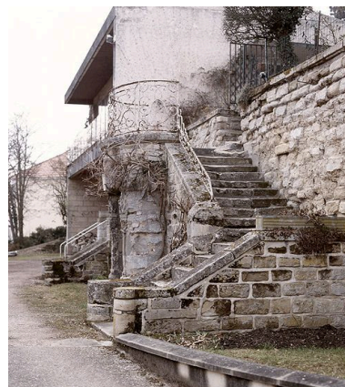
Vue du belvédère du XVIIIe siècle se trouvant à côté de la maison. Phot. Laurent Kruszyk IVR11_20067800172XA
