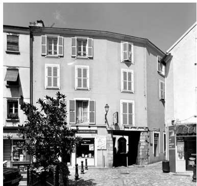
Façade sur rue : vue d'ensemble. Phot. Stéphane Asseline IVR11_20037700653V
