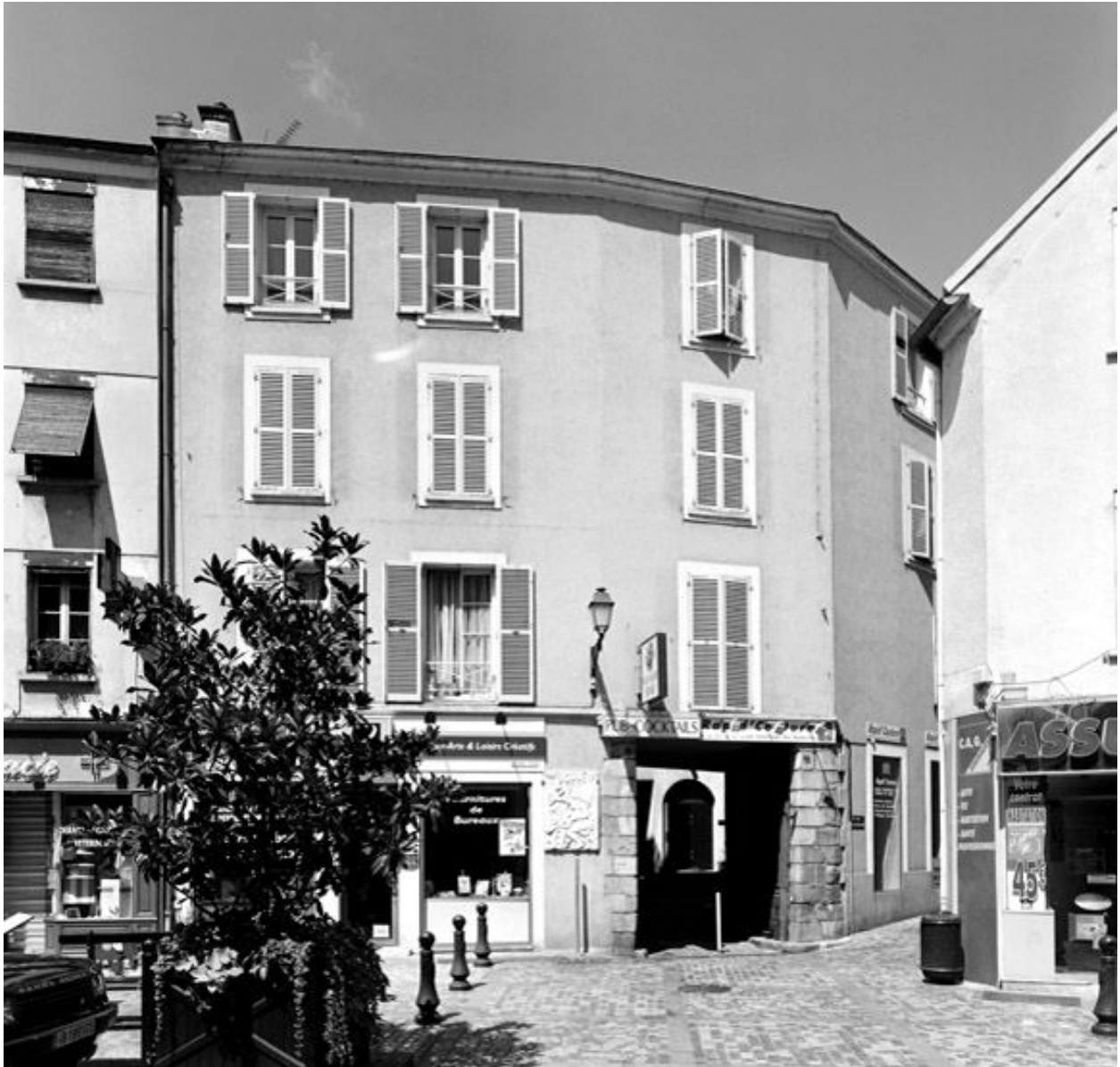
Façade sur rue : vue d'ensemble.
