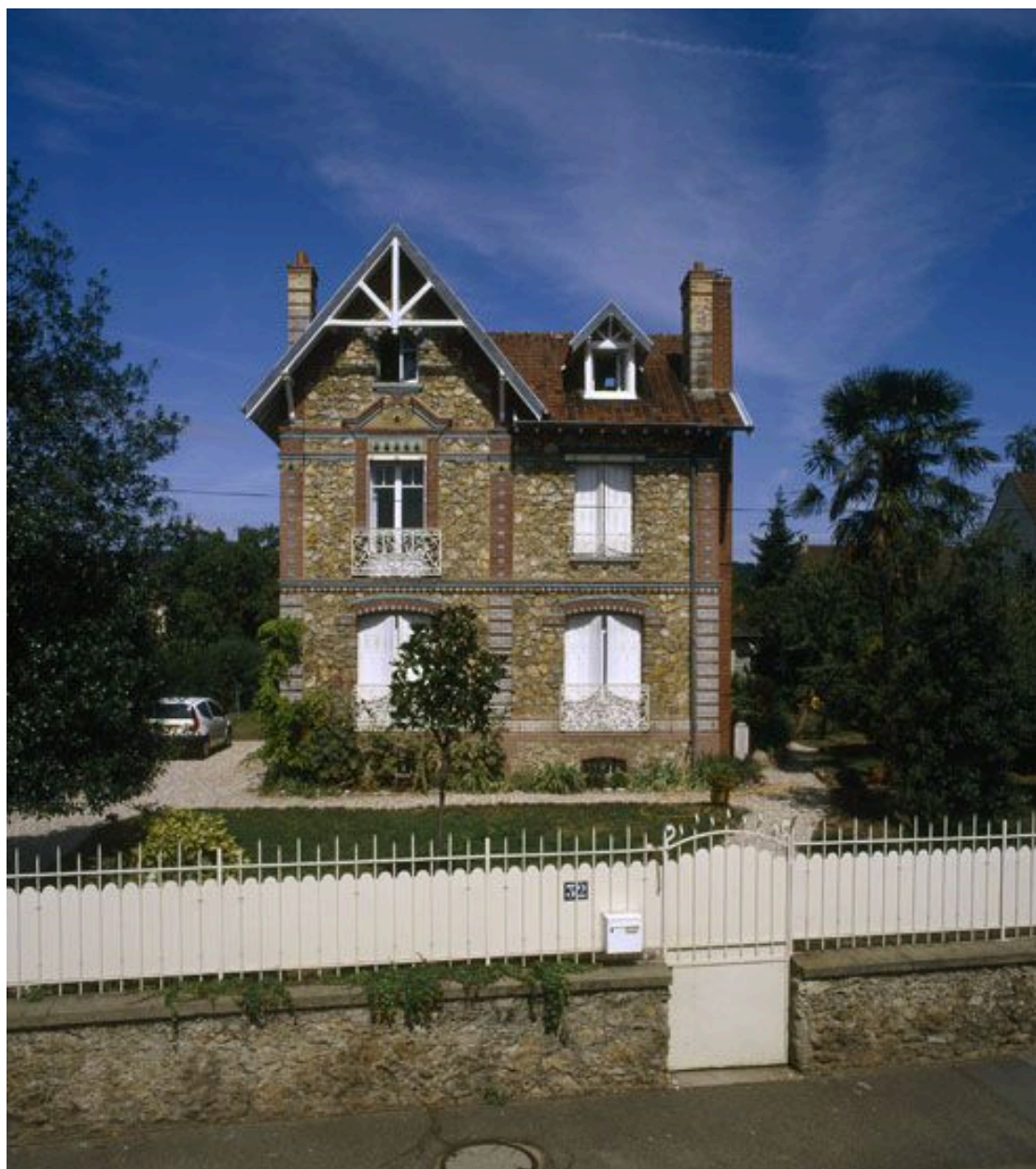
Vue d'ensemble de la façade sur rue.
