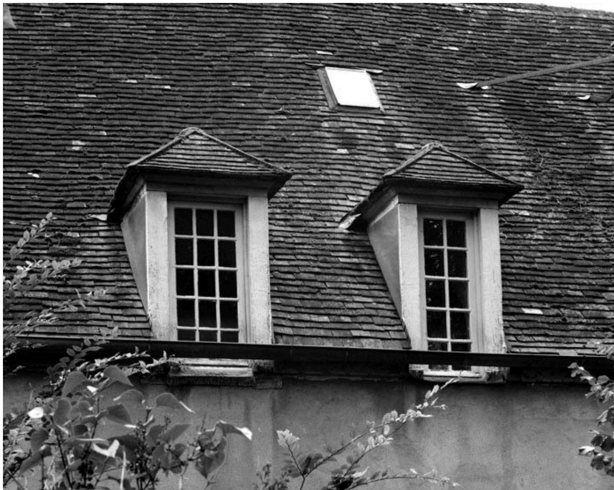
Lucarnes à croupe de la façade arrière.
