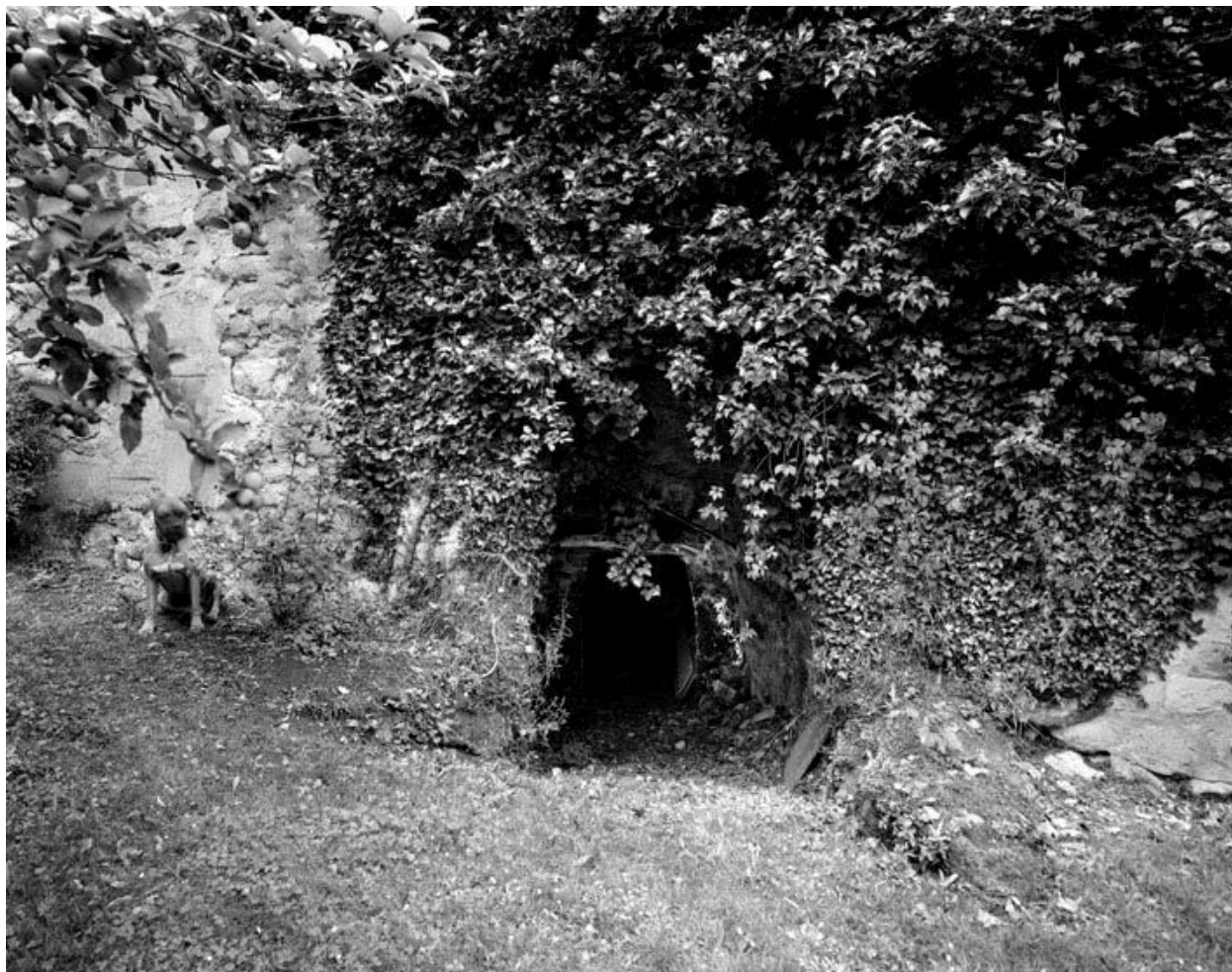
Entrée d'une ancienne carrière creusée dans le coteau à l'arrière de la maison.
