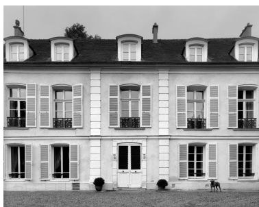
La façade principale, vue des travées centrales. Phot. Laurent Kruszyk IVR11_20077800181V
