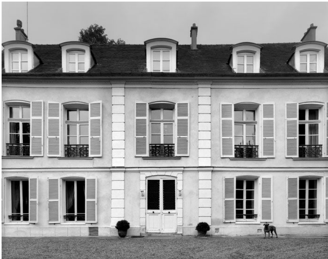
La façade principale, vue des travées centrales.
