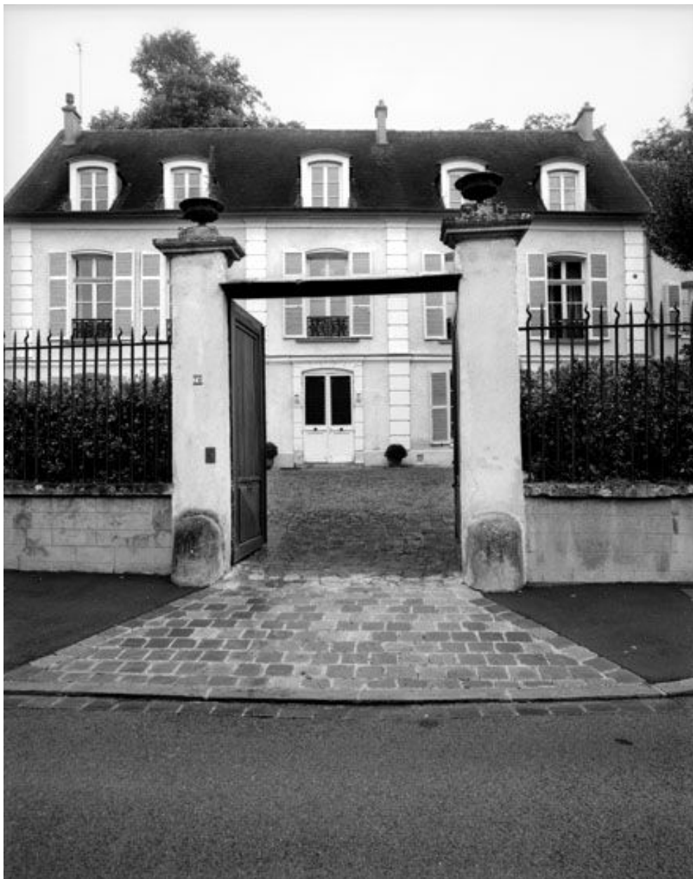
Le portail et la cour d'entrée, vue d'ensemble.
