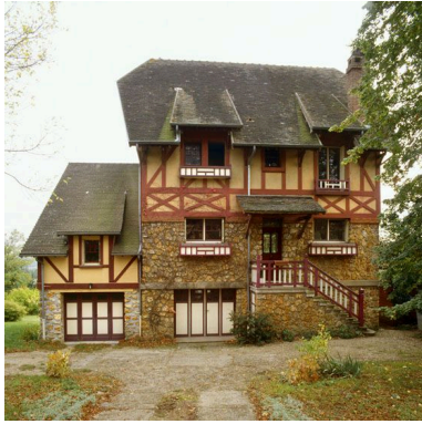
Vue d'ensemble de la façade sur rue. La partie gauche est une adjonction récente. Phot. Laurent Kruszyk IVR11_20067800909XA
