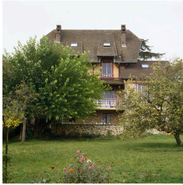
La façade sur jardin. Phot. Laurent Kruszyk IVR11_20067800911XA
