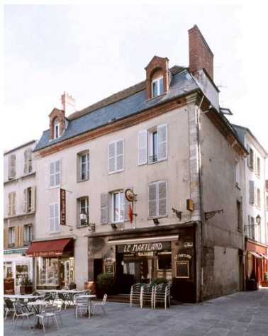
Vue d'ensemble. Phot. Stéphane Asseline IVR11_20057700233VA
