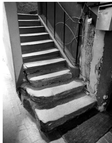
Départ de l'escalier. Phot. Stéphane Asseline IVR11_20027700748X
