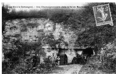
Maurecourt. Anciennes carrières devenues champignonnières. Photographie. (Collection particulière). Phot. Pascal (reproduction) Durand, Autr. Louis Rémy Sabbattier IVR11_20087800473NUC2
