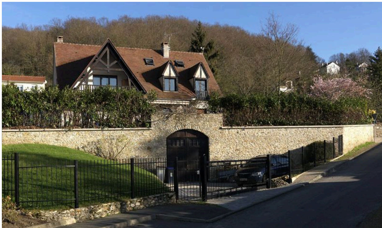
Anciennes entrées de carrières à gypse à Chanteloup.
