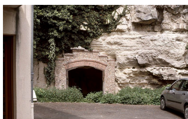
Entrée d'une ancienne carrière à Andrésy, rue de la Gare. Phot. Laurent Kruszyk IVR11_20067800396XA
