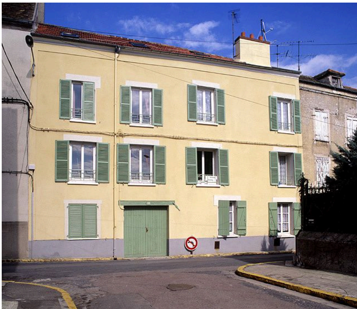
Vue de la façade.
