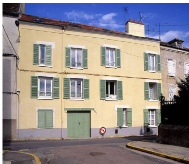
Vue de la façade. Phot. Stéphane Asseline IVR11_20047700439XA
